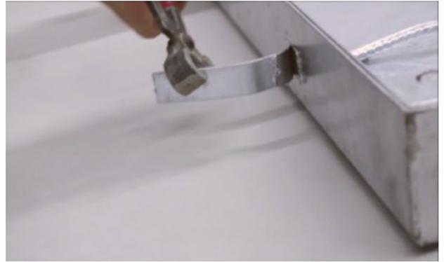
Dépliez les ancrs de fixation de telle façon d'assurer plus tard un bon ancrage du châssis dans le béton.
