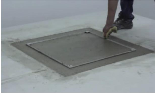
Laissez le béton durcir. Une fois le châssis pris dans le béton, le couvercle de regard ne peut plus glisser. Aussitôt que le béton a atteint environ 80% de sa fermeté, nettoyez les parties visibles du couvercle car il est laborieux de les nettoyer par la suite.
