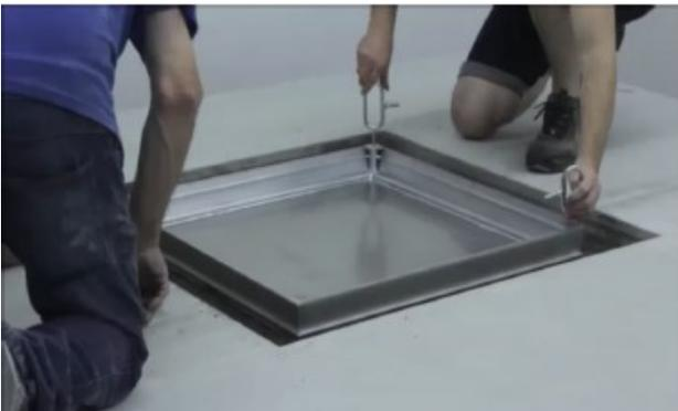
Fermez le couvercle et vissez-le. Posez les capuchons. Vérifiez encore une fois la mise à niveau de la trappe par rapport au sol fini.
