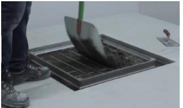
Posez la grille d'armature, remplissez entièrement le couvercle et laissez éventuellement le niveau nécessaire pour la pose de revêtement. Scellez la trappe sur tout le pourtour en laissant éventuellement le niveau nécessaire à la pose du revêtement. Assurez-vous que la grille d'armature soit prise entièrement dans le béton et protégez les vis et les rebords du couvercle contre les éventuelles éclaboussures.
